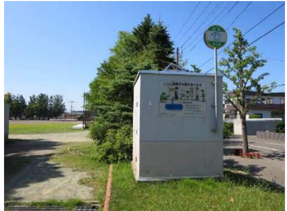
公園に設置された緊急貯水槽
